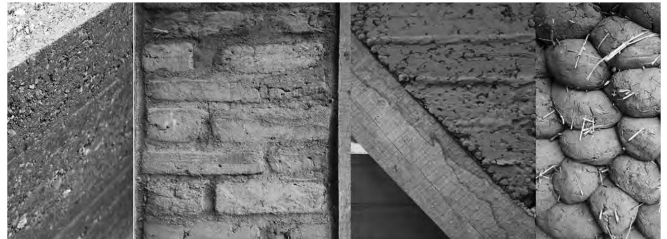
Abb. 3: Lehm-bautechniken (vlnr): Stampflehm, Lehmziegel, Leichtlehm, Wuzelmauer; Foto: Verfasserin
