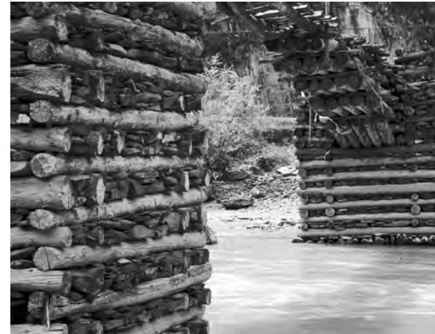
Abb. 1: Auslegerbrücke in Daqiongda, Bezirk Aba, Sichuan, China; Foto: Verfasser
