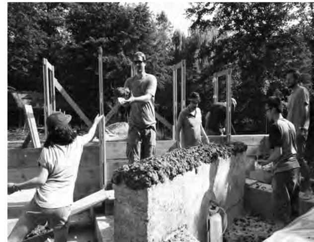
Abb. 1: Errichtung einer Wellerwand; Foto: Verfasserin
