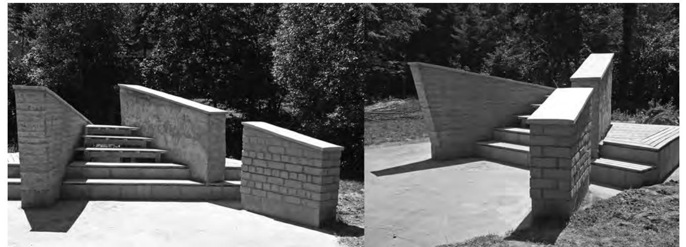
Abb. 2: Lehmskulptur - Stampflehmwand, Wellerwand, Lehmziegelwand, Entwurf: Denise Kissling, design-build; Foto: Verfasserin
