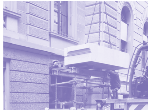
▲ Baustellenfoto des Neuen Eingangs für die Gerichte – Hilda von Clauss Kahl Merz Atelier, Basel (Credits: Clauss Kahl Merz)
